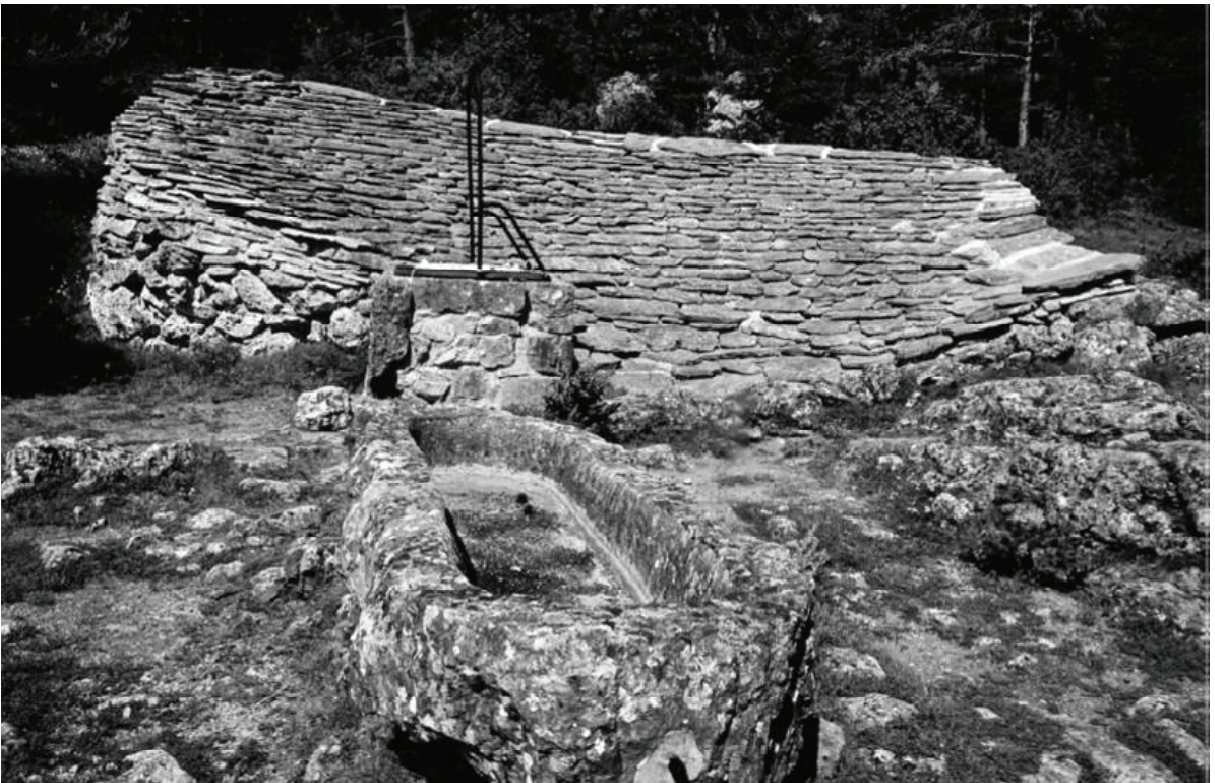
Toit citerne (Saint Jean de Balme)
