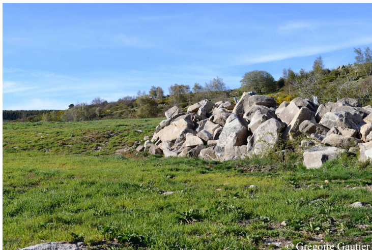
Illustration 28: Travaux de dérochage effectués dans les secteurs granitiques où la pierre, trop dure, ne peut être broyée.
