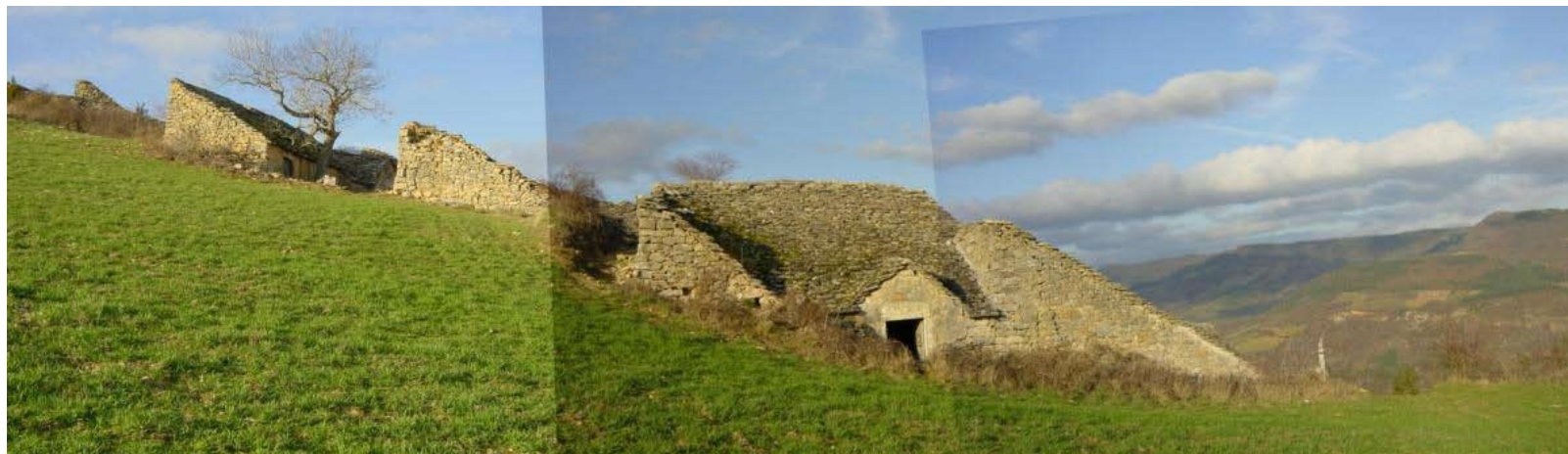
Vue du sud Vue de l'est
