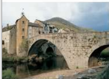
Le village du Pont-de-Montvert possède un pont du xv e siècle et une jolie tour de l'Horloge.
