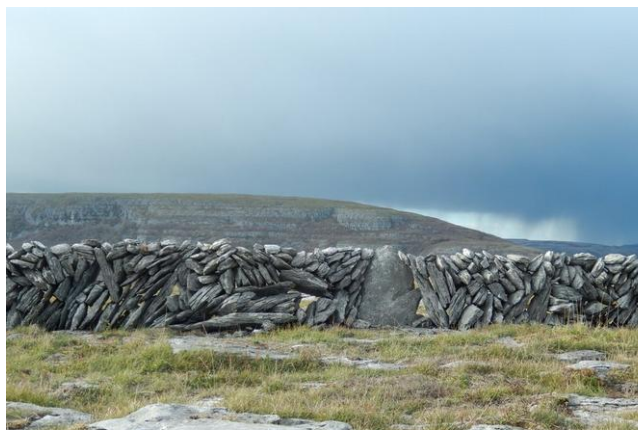
Détail muret en pierre sèche © Entente C&C
